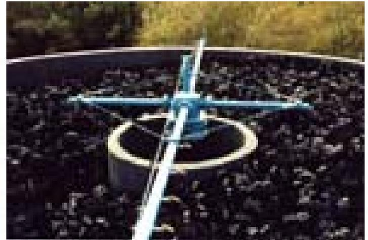
Filtro biológico de baixa carga com distribuidor rotatório
