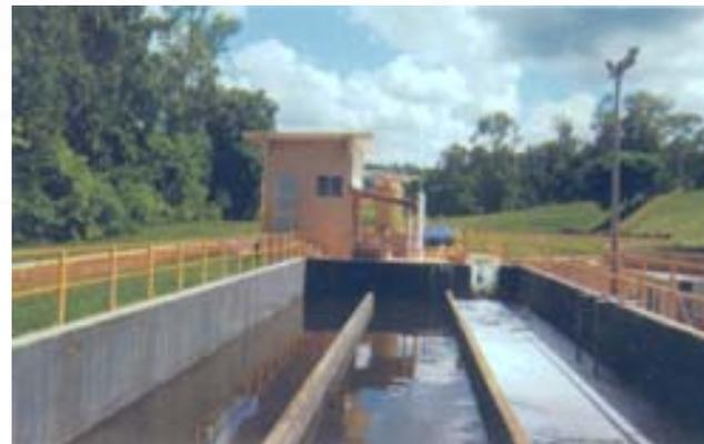
ETE Caçadores (CAMBÉ-PR) - Tanque de contacto do Processo de Dióxido de Cloro.
